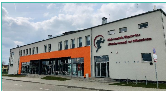
Zdj. 9 Hala sportowa Ośrodka Sportu i Rekreacji w Mosinie przy ul. Krasickiego 16
