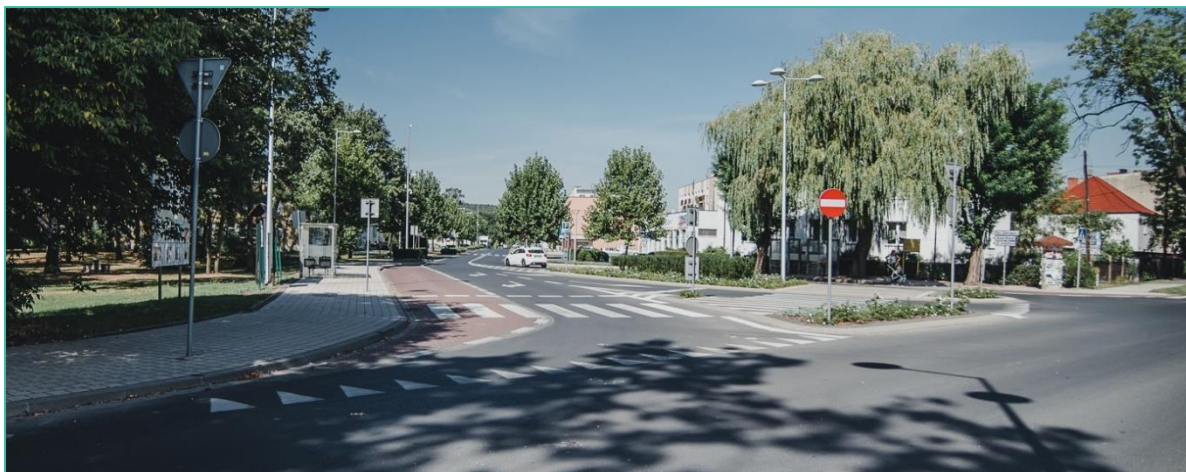
Zdj. 25 Przystanki autobusowe przy ul. Dworcowej w Mosinie
