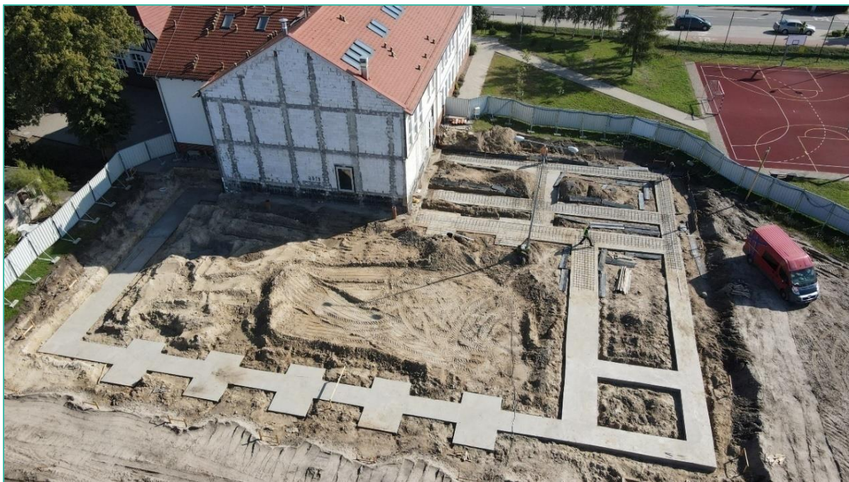
Zdj. 79 Rozbudowa SP w Krosinku o salę gimnastyczną i część dydaktyczno-wychowawczą
