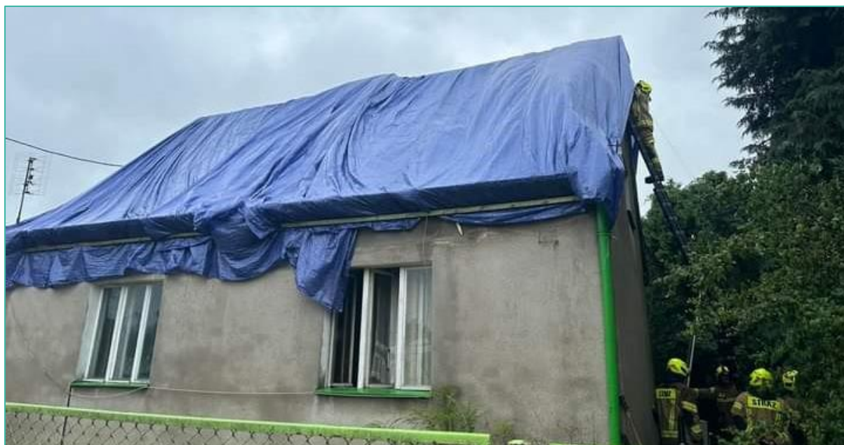
Zdj. 76 Zabezpieczenie dachu
