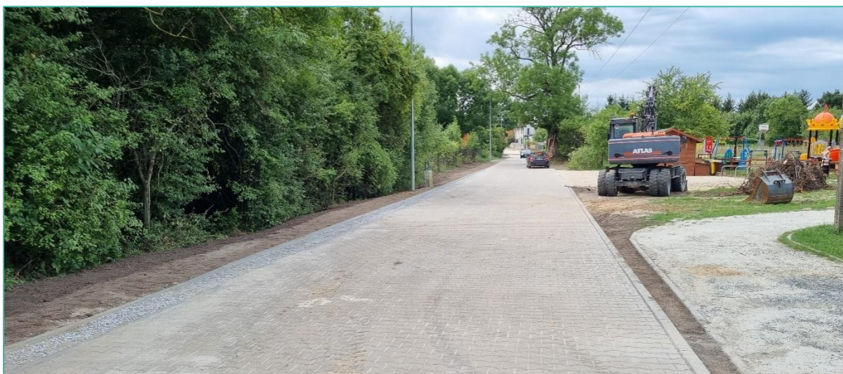
Zdj. 23 Przebudowa ulicy bocznej od ul. Pożegowskiej w Mosinie
