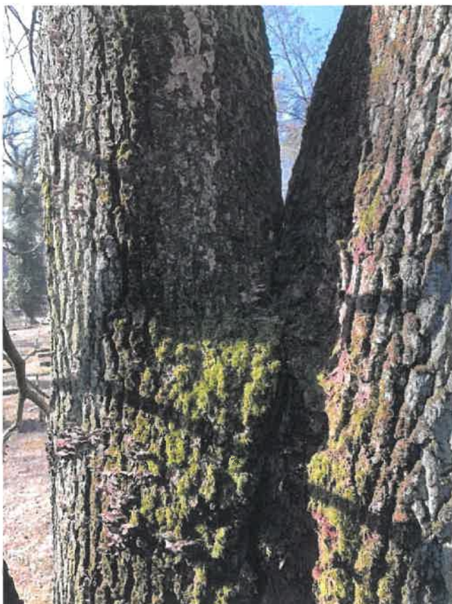
FOT. 1.5. WIDOCZNE PĘKNIĘCIE POMIĘDZY PRZEWODNIKAMI.
