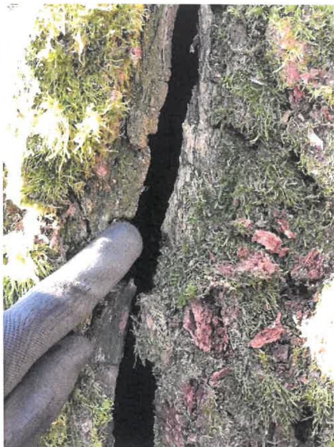
FOT. 1.6. ZBLIŻENIE NA PĘKNIĘCIE W NASADZIE KORONY
